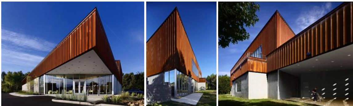
صورة (42) الواجهات الخاجية للمبنى و اسلوب توظيف الكتلة الهرمية في مدخل المبنى مع استخدام الخطوط المستقيمة بمسافات متساوية مما يوحي بالانتظام و الصعود لأعلي. [29]
