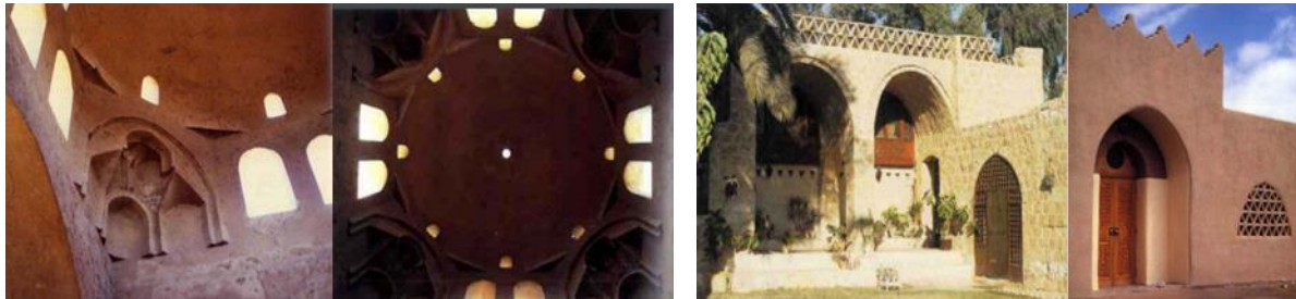
صورة (38) استخدام وحدة المقرنص المكبر بما يحمله من مثلث و هرم في زاوية القبلة لمسجد قرية القرنة الجديدة [8]
