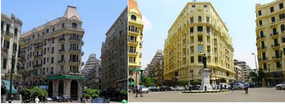
صورة (39) الشكل المثلث في المسقط الأفقي لمباني من القرن الماضي بأحد ميادين القاهرة و الناتج من شكل قطعة الأرض و اسلوب استغلاله بالمبني في الطوابق المختلفة. [28]
